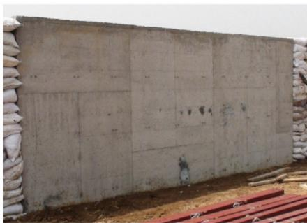
图1 混凝土抗爆墙<sup>[19]</sup>
