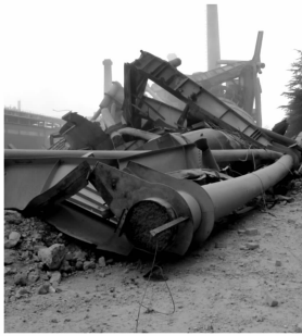
图 11 钢塔立窑爆堆情况
