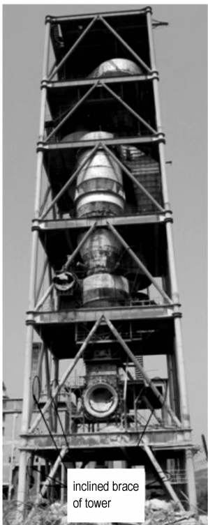
图5 塔架立窑实际结构
